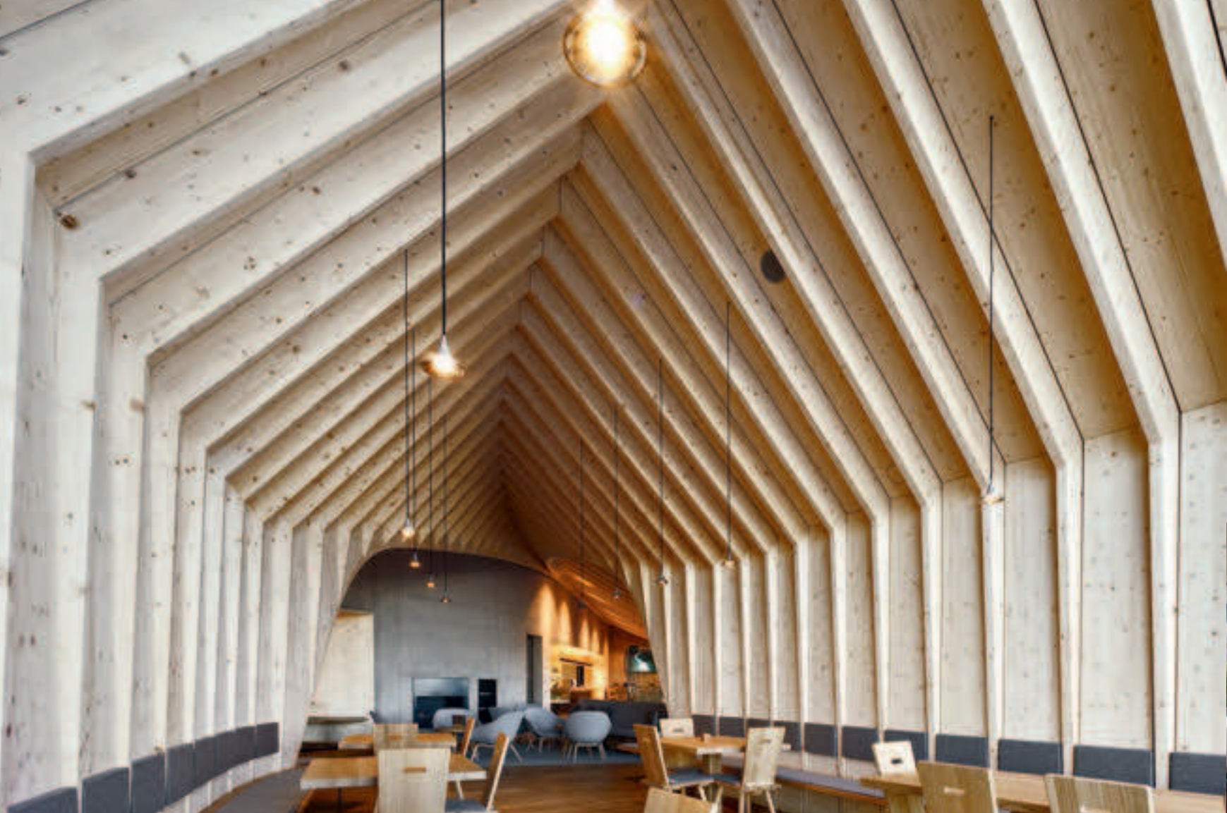
Интерьер ресторана Горной хижины Оберегген. Конструкция, возведенная из деревянных деталей (LignoAlp), повторяет классическую кровлю местного домика, интерпретированного в современном духе
